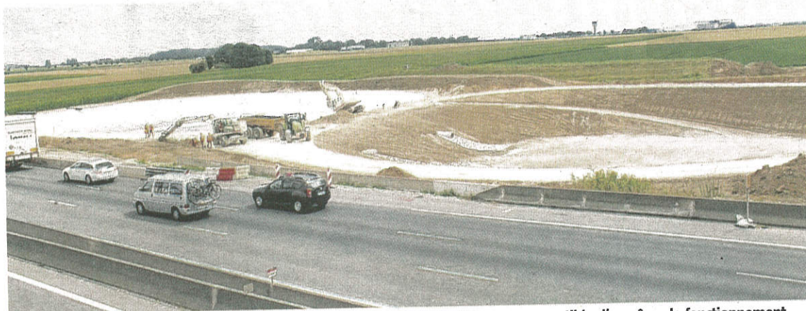
À l'issue des travaux, l'ouvrage sera clôturé pour éviter l'apparition d'une faune susceptible d'en gêner le fonctionnement.
