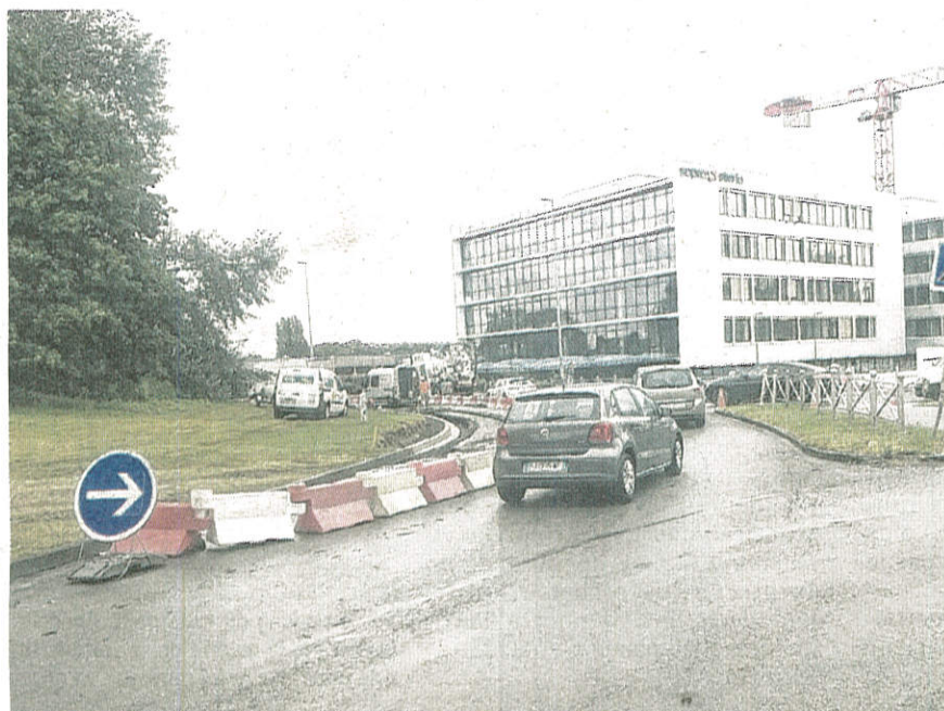
Les travaux ont démarré à l'intérieur du rond-point Saint-Ghislain, qui va passer par endroits de trois à deux voies.
