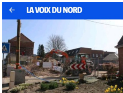
La salle Paul-Bussine a été démolie. Le chantier est en bordure de rue mais la circulation reste relativement fluide.
