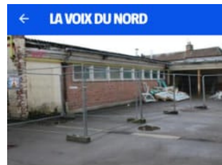
Les classes vertes des années 1950 sont en cours de démolition.
