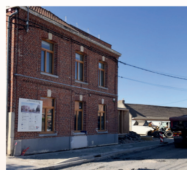
Été 2022 : dernière réfection en date de l'artère principale de la commune, reclassée en chemin métropolitain en 2019
